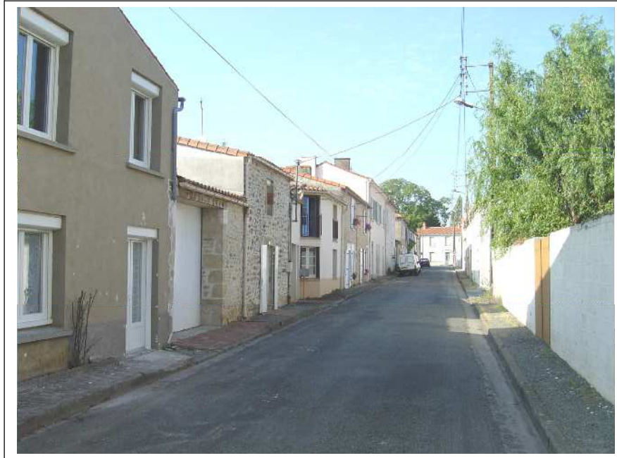
Rue Guinot, bâti ouvrier très intéressant, par la densité bâtie qu'il crée en respectant l'intimité des parcelles privées
